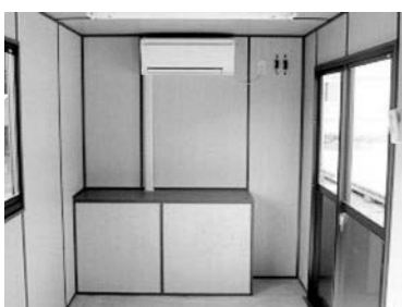
CH-4500、CH-5400 室内（エアコン取付側）
